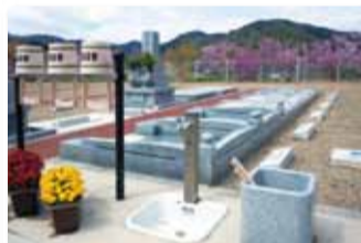
1列はさみに設置された水くみ場
